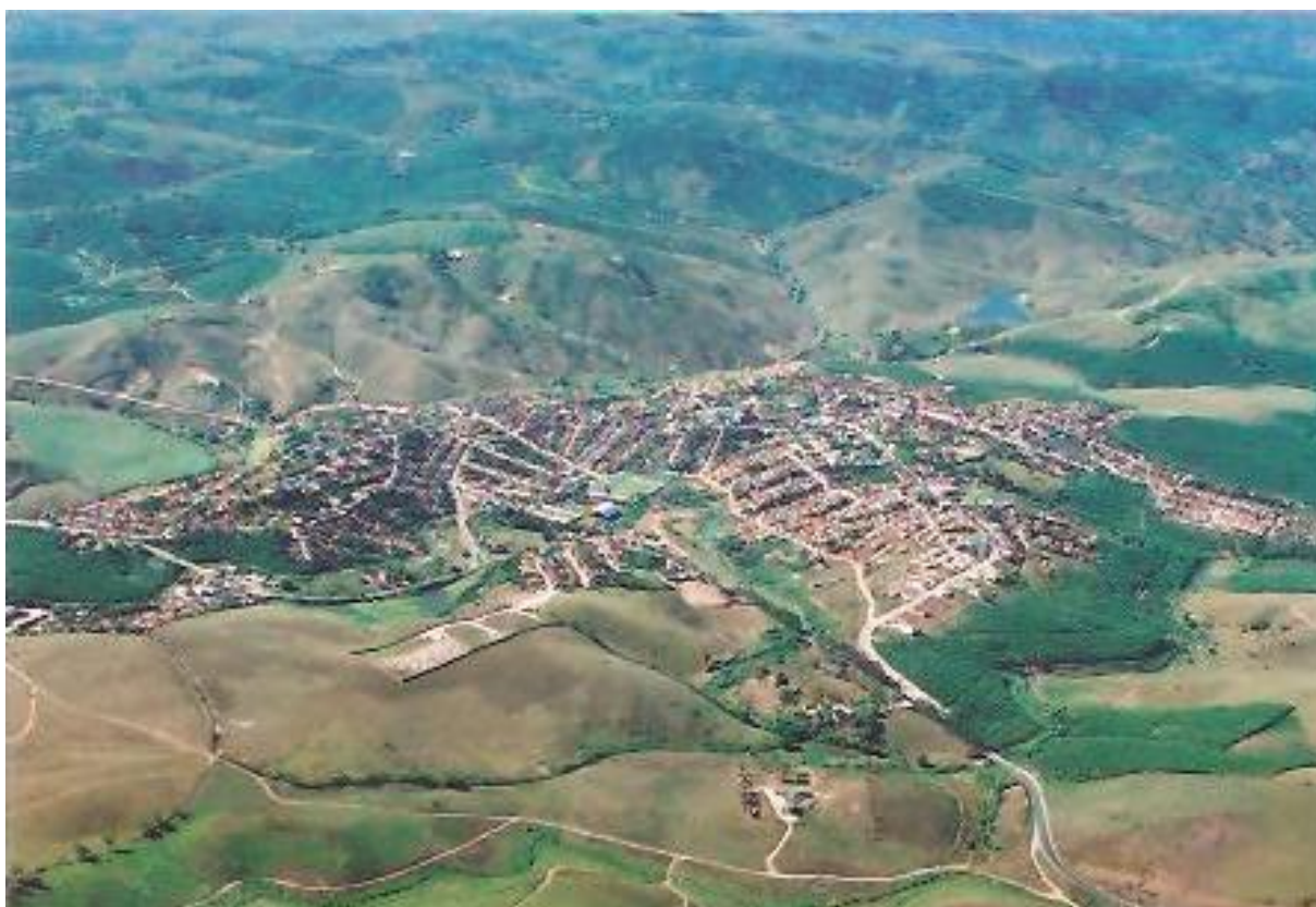
Figura 1 – Cidade de Macaparana com vista aérea
